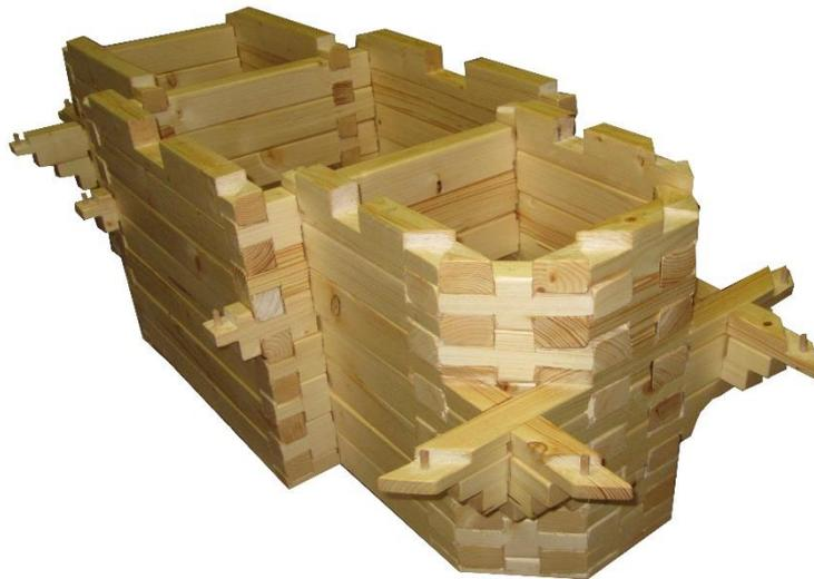
Eckverbindung: Schwalbenschwanzblatt, kein Vorkopf;
